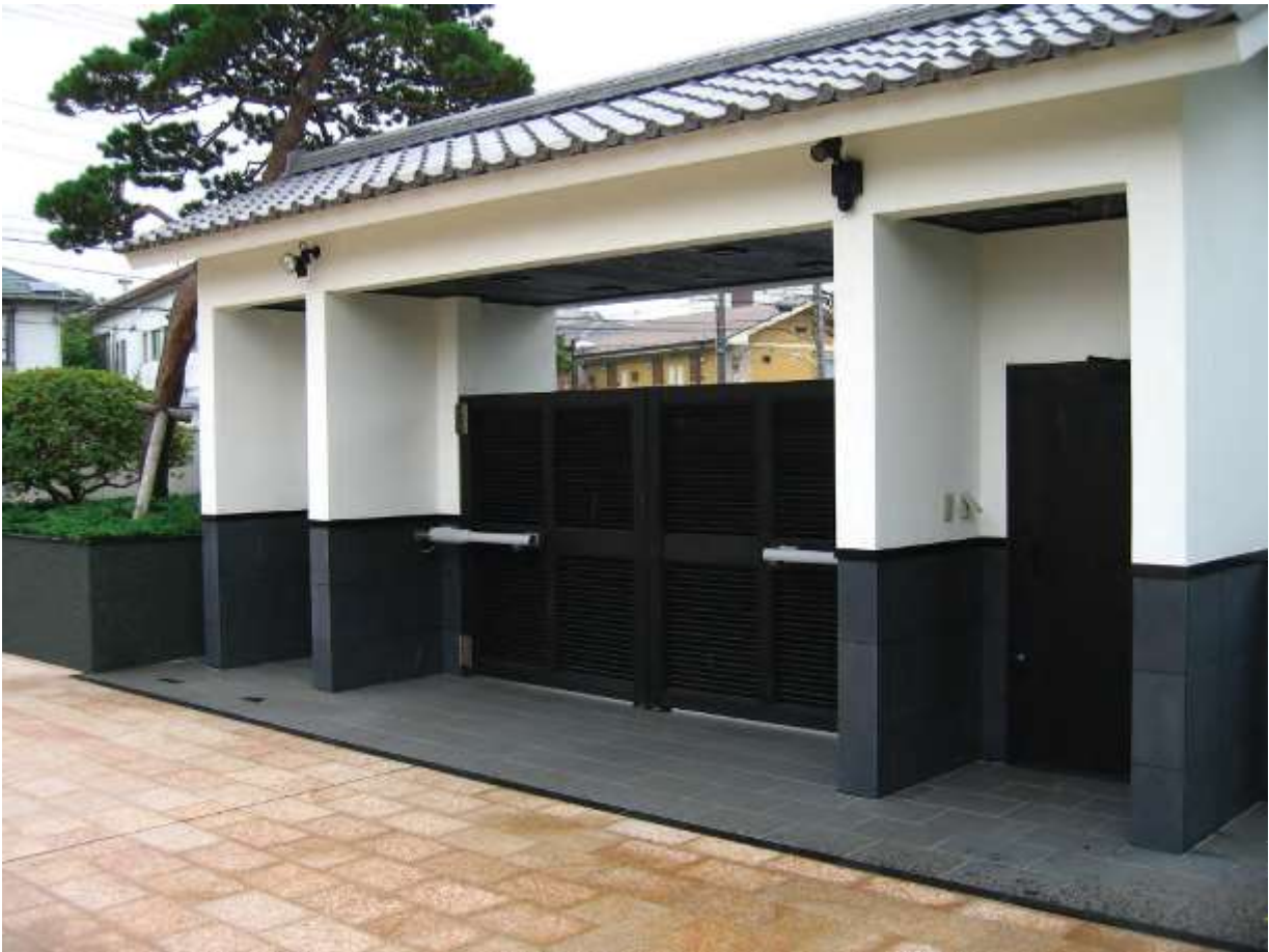
正門腰壁 山西黒 水磨き 床 山西黒 バーナー 外構床 G682(サビ石) バーナー
